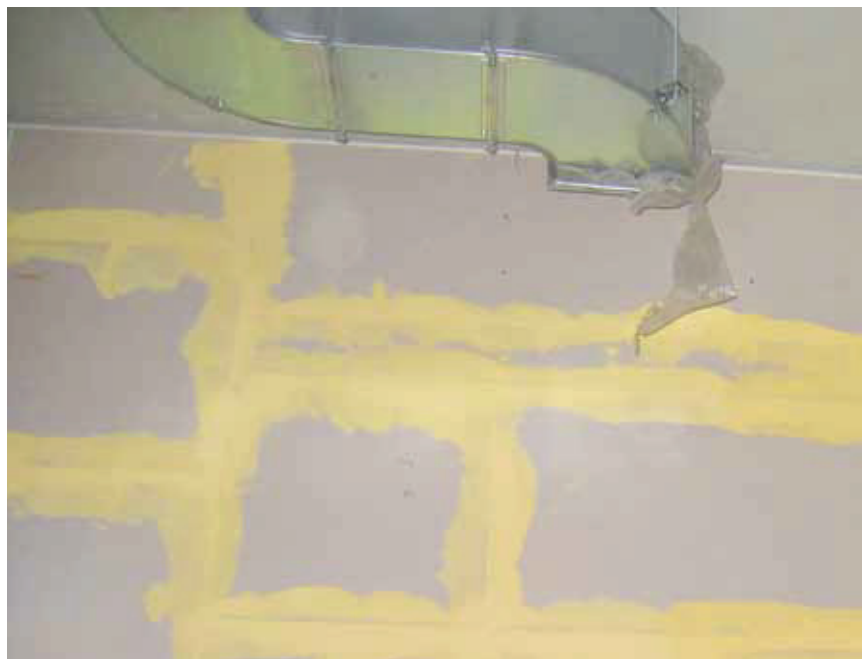
Ülalolev pilt kujutab Safeboardi plaadiga kaetud ja pahteldatud seinu, millele viimase kihina paigaldatakse Norgipsi kipsplaat Standard või Hard. Tasub tähele panna, et maksimaalse kiirguskaitse saavutamiseks ei kasutata Safeboardi plaadi liitekohtades vuugilinti. Välimise kattekihi kipsplaat Norgips Standard või Hard pahteldatakse alati koos paberist vuugilindiga.
